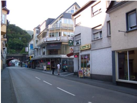
Abb. 23 Städtebauliche Defizite: „Eingangstor“ Endertstraße, Verbindung Kirchgasse
