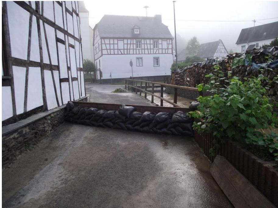
*Bild 30: Dammbalken mit Sandsäcken*
