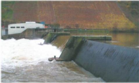
Die Mosel wurde ausgebaut, damit auch in Niedrigwasserzeiten die Schifffahrt möglich ist und Energie in den Wasserkraftanlagen gewonnen werden kann. Beim Ausbau war zu gewährleisten, dass sich die Hochwassersituation für die Anwohner nicht verschlechtert. Dies wurde in Modellrechnungen nachgewiesen und durch Messungen nach dem Ausbau bestätigt.
