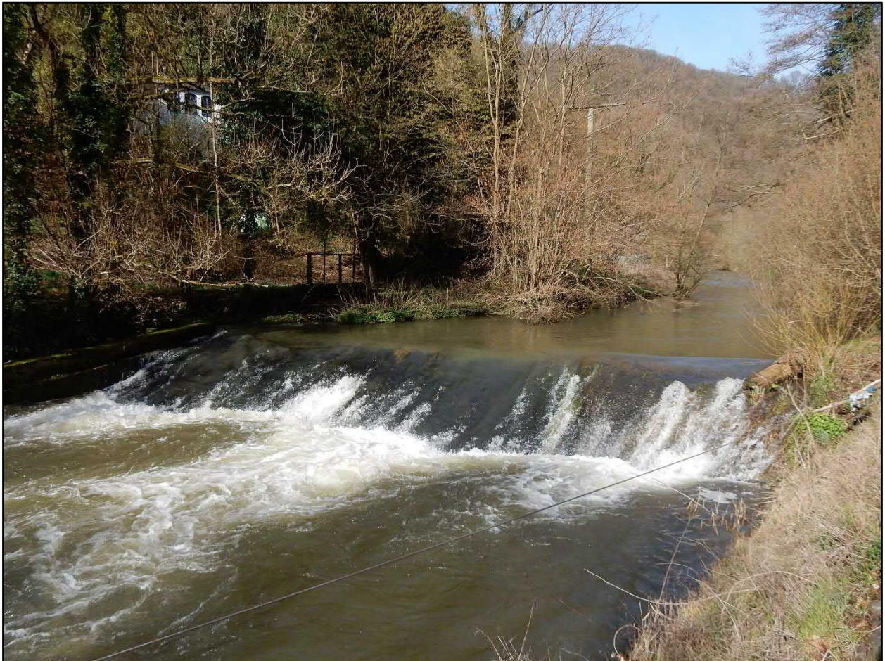
Abbildung 11: Querbauwerk (Wehr) im Endertbach innerhalb der VG bei Moselkern (Foto: Enviro-Plan GmbH)
