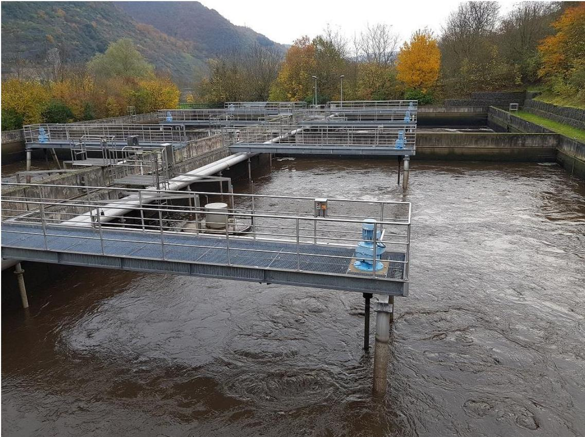
Abb. 5: SB-Reaktoren
