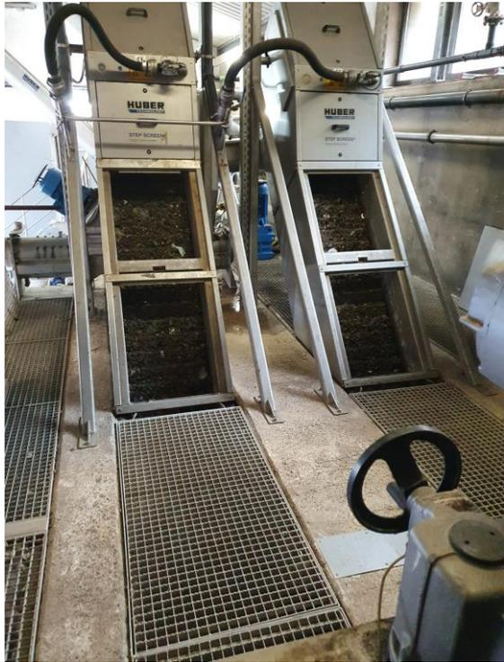
Abb. 3: Stufenrechen
