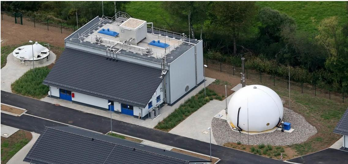
Abb. 18: 2-stufige Kompaktfaulung Kläranlage Westerburg
